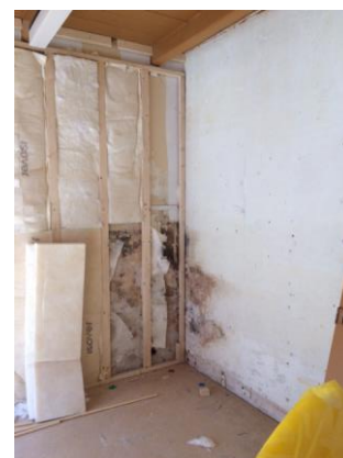
De voorkamer wordt geïsoleerd.
