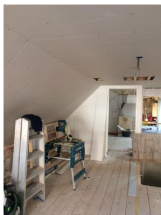
De bovenverdieping is bijna klaar.
